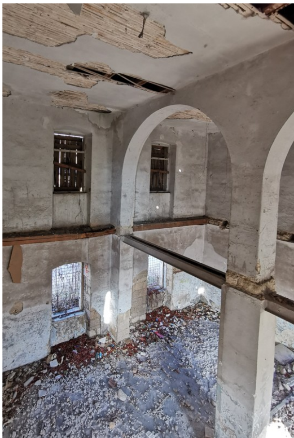
Detalj lučnih nosača u sjeveroistočnom dijelu zgrade
