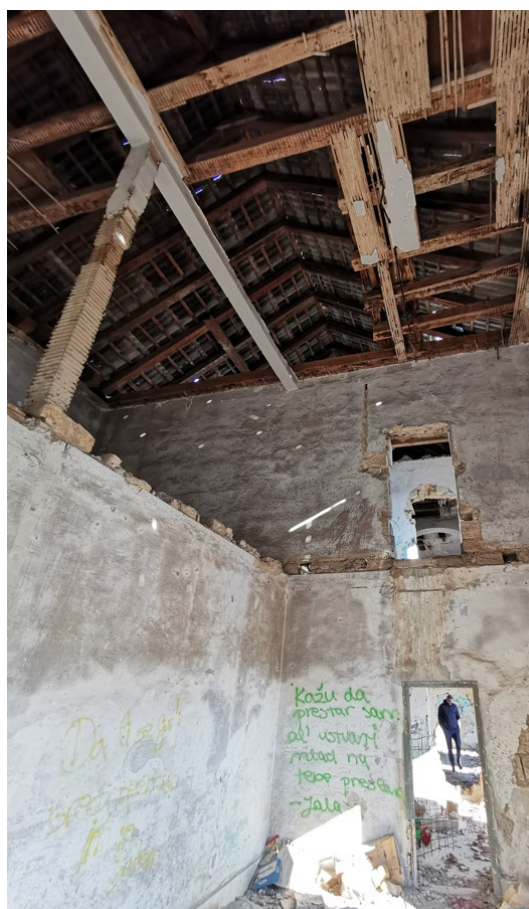
Detalj unutrašnjeg zida u jugozapadnom dijelu prizemlja
