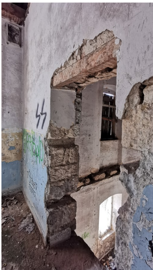
Detalj unutrašnjeg nosivog zida na etaži 1. kata
