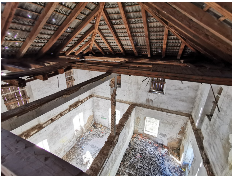
Prikaz ostataka međukatnih konstrukcija iznad prizemlja te iznad 1. kata
