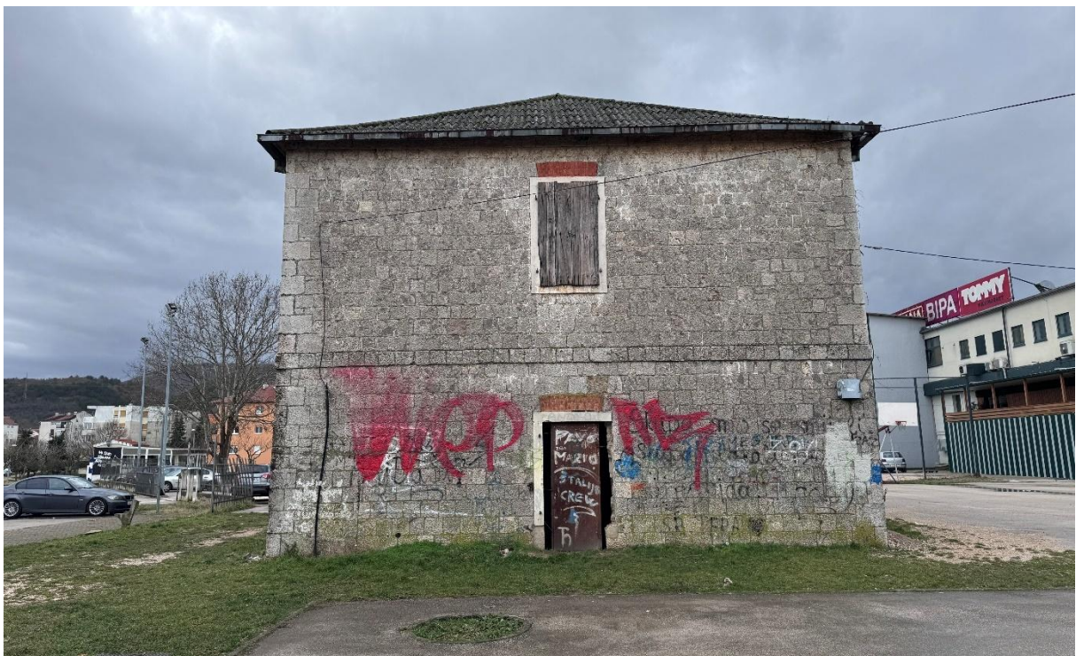
Slika 2. Pogled na sjeveroistočno pročelje Zgrade na Štaliji
