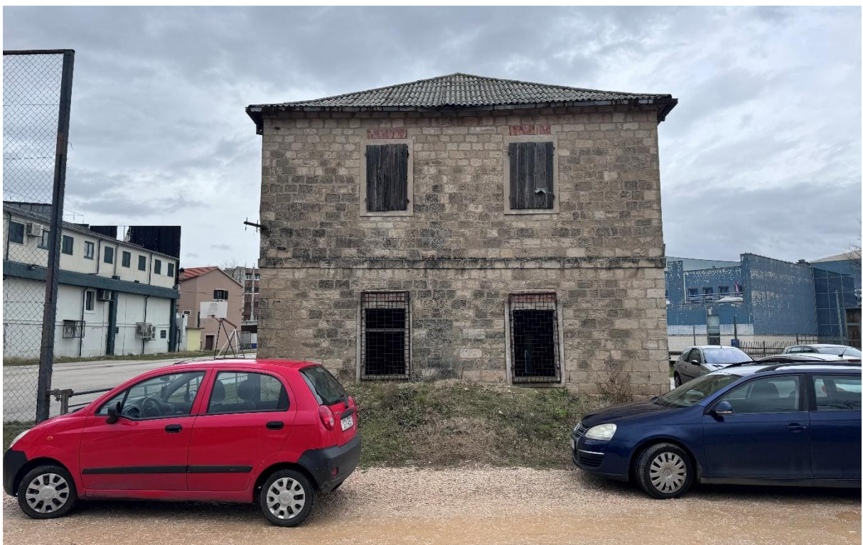
Slika 4. Pogled na jugozapadno pročelje Zgrade na Štaliji
