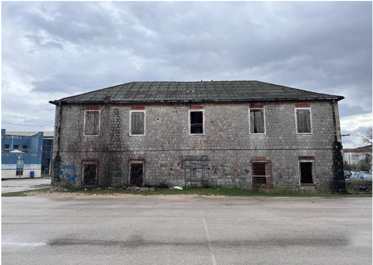
Slika 1. Pogled na sjeverozapadno pročelje Zgrade na Štaliji
