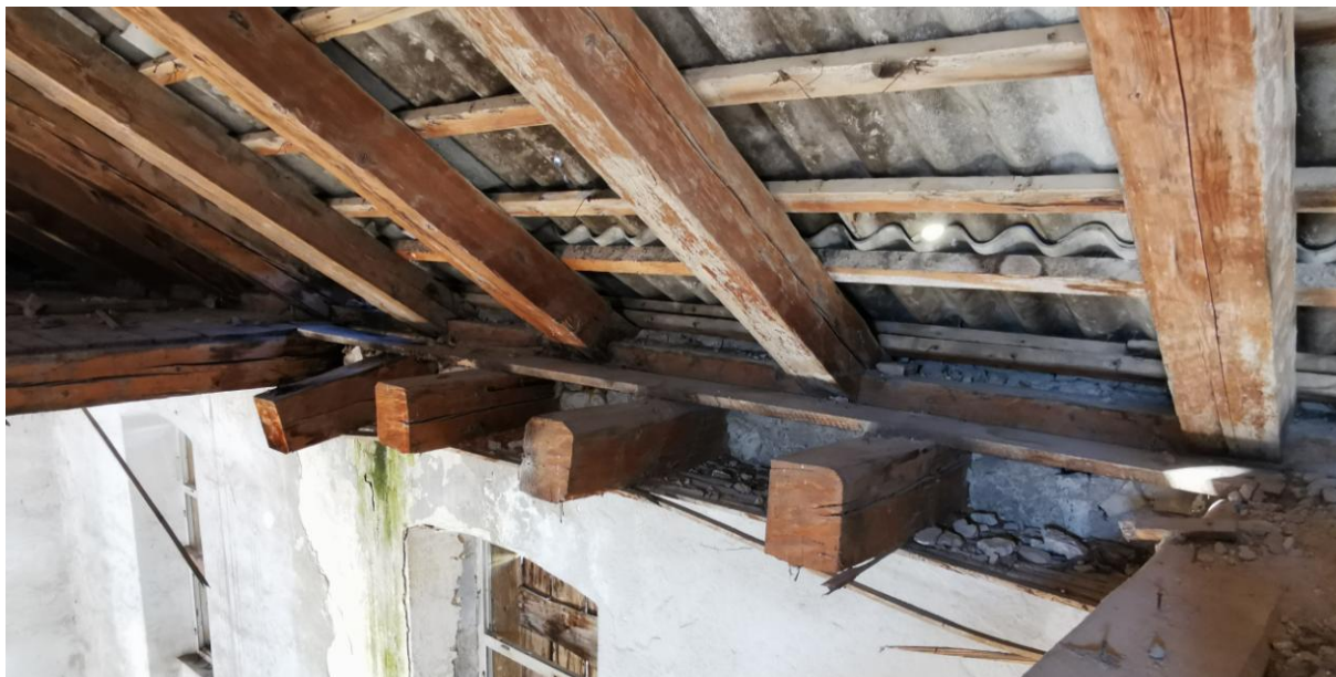
Slika 10. Ostatci drvenih greda stropa kata
