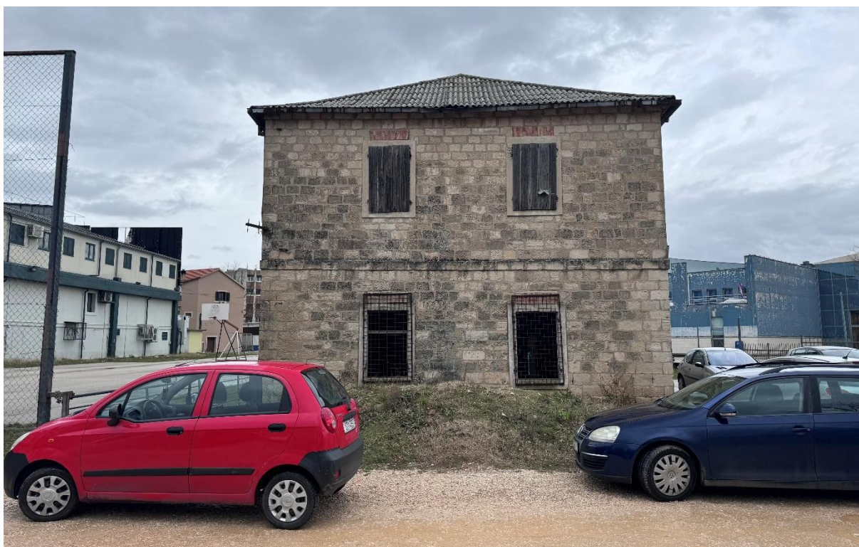
Slika 6. Pogled na jugozapadno pročelje Zgrade na Štaliji
