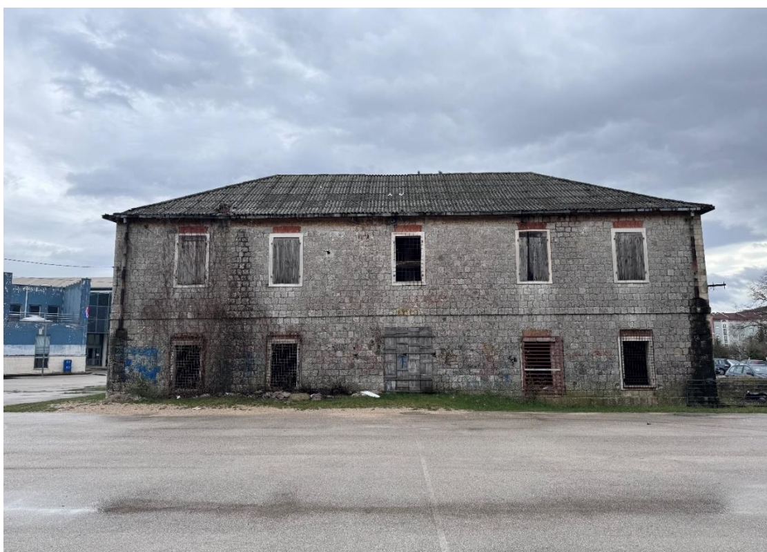
Slika 3. Pogled na sjeverozapadno pročelje Zgrade na Štaliji
