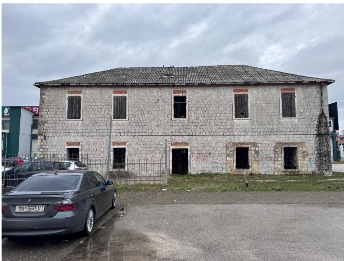
Slika 5. Pogled na jugoistočno pročelje Zgrade na Štalji
