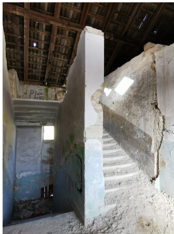
Slika 7. i 8. Postojeće dvokrako stubište sa gazištima od monolitnog kamena
