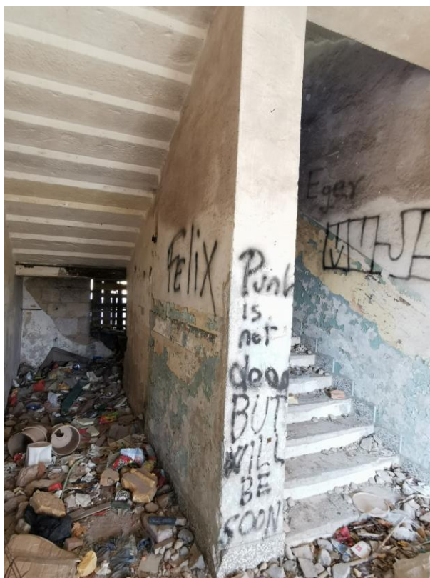
Slika 7. i 8. Postojeće dvokrako stubište sa gazištima od monolitnog kamena
