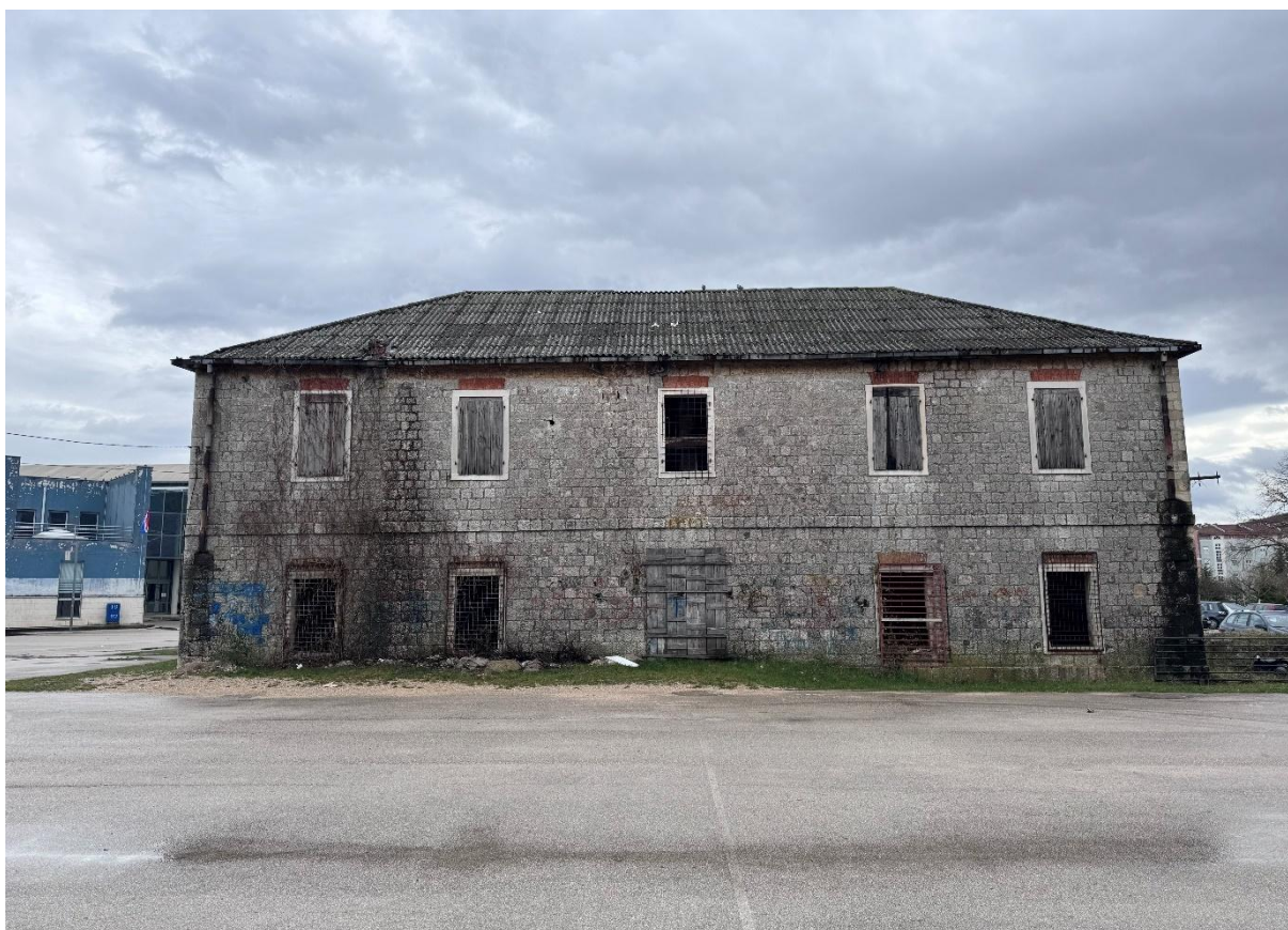
Slika 3. Pogled na sjeverozapadno pročelje Zgrade na Štaliji
