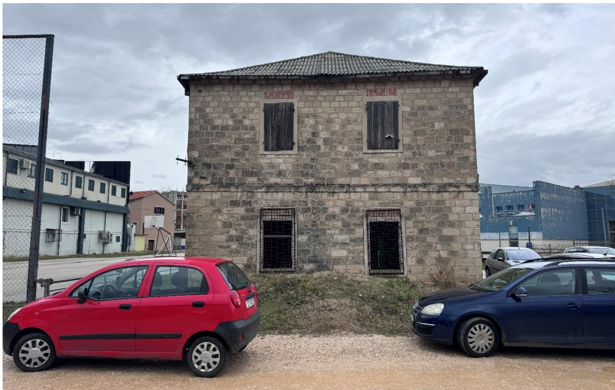
Slika 6. Pogled na jugozapadno pročelje Zgrade na Štaliji
