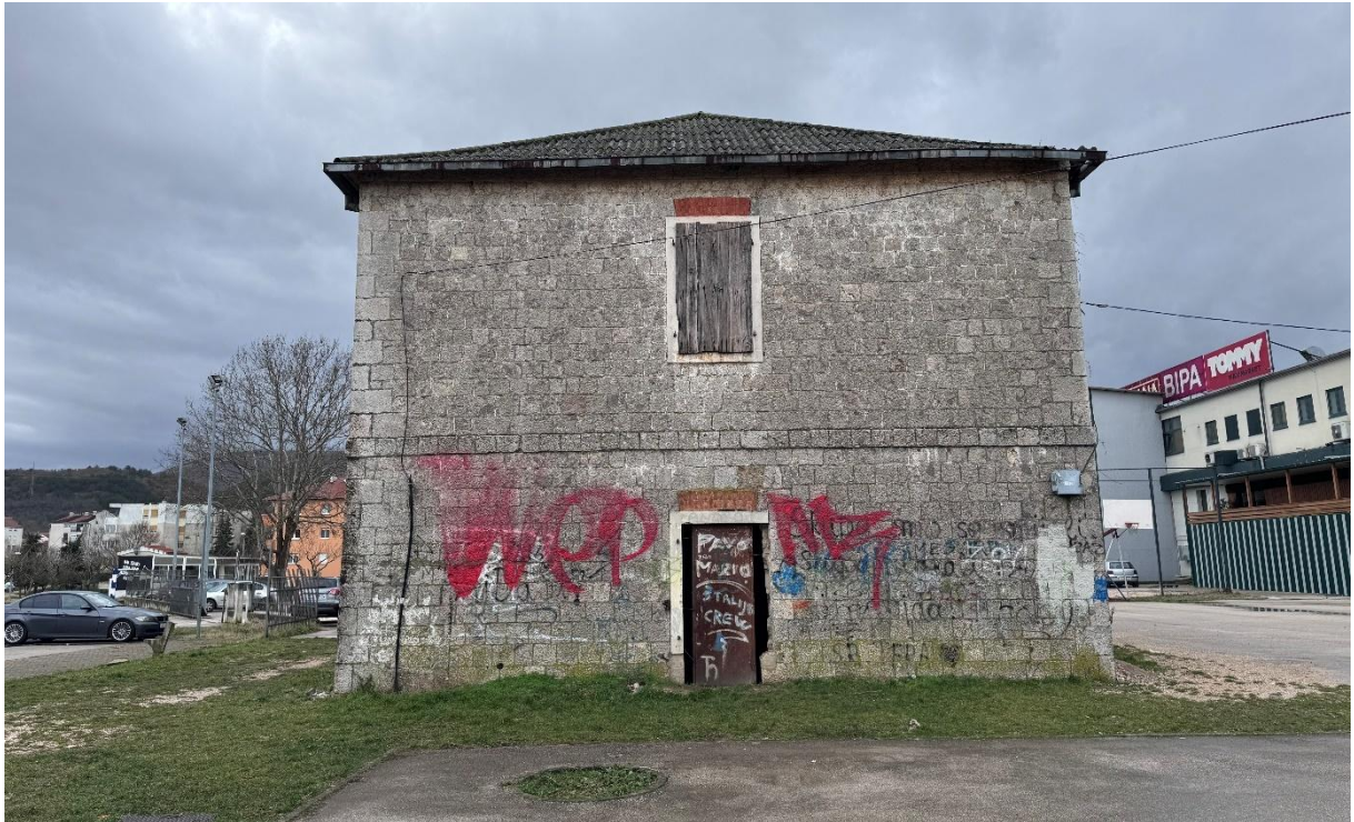
Slika 4. Pogled na sjeveroistočno pročelje Zgrade na Štaliji
