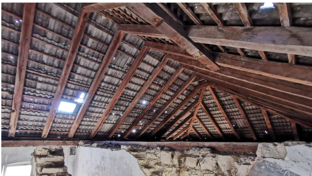
Slika 11. Postojeći rogovi krovne konstrukcije
