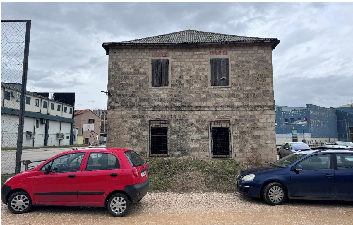
Slika 6. Pogled na jugozapadno pročelje Zgrade na Štaliji
