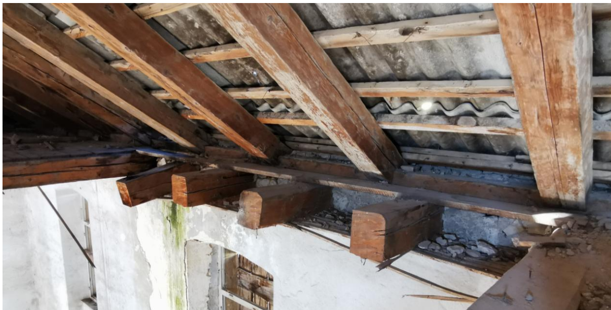
Slika 10. Ostatci drvenih greda stropa kata
